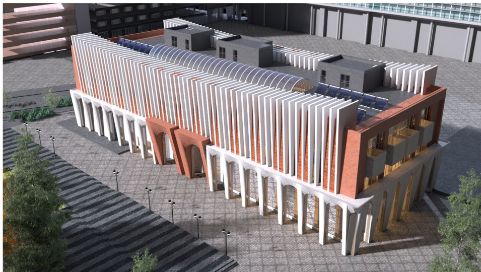
مجتمع کلاس های دانشگاه بناب کارفرما: دانشگاه بناب موقعیت: بناب، آذربایجان شرقی زیر بنا: ۳۸۰۰ مترمربع تعداد طبقات: ۴ طبقه سازه ای سال: ۱۴۰۱ در مرحله اجرا
